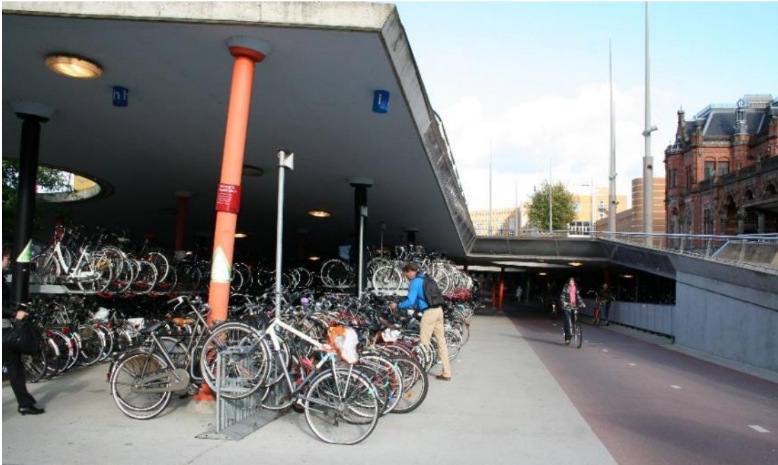
Figur 7.3 Eksempel på cykelsti, der forløber gennem cykelparkeringsanlæg ved Groningen station i Holland. Foto: COWI.
