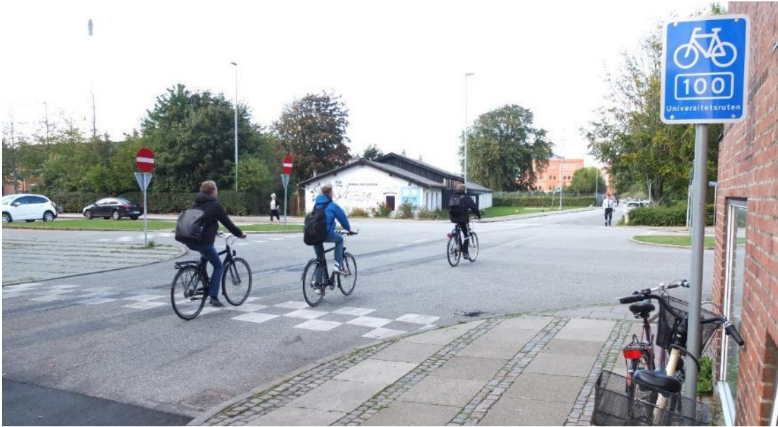
Figur 4.25 Eksempel på vigepligtskryds ved Fyensgade i Aalborg, hvor vigepligten på pendleruten er vendt til fordel for cyklister. Foto: Brian Høj, Aalborg Kommune.
