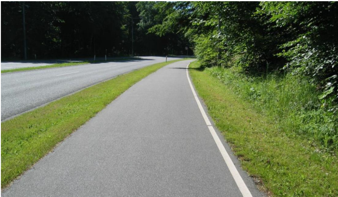
Figur 4.18 Enkeltrettet sti på 2,5 m langs vej i åbent land i Furesø Kommune. Foto: COWI
