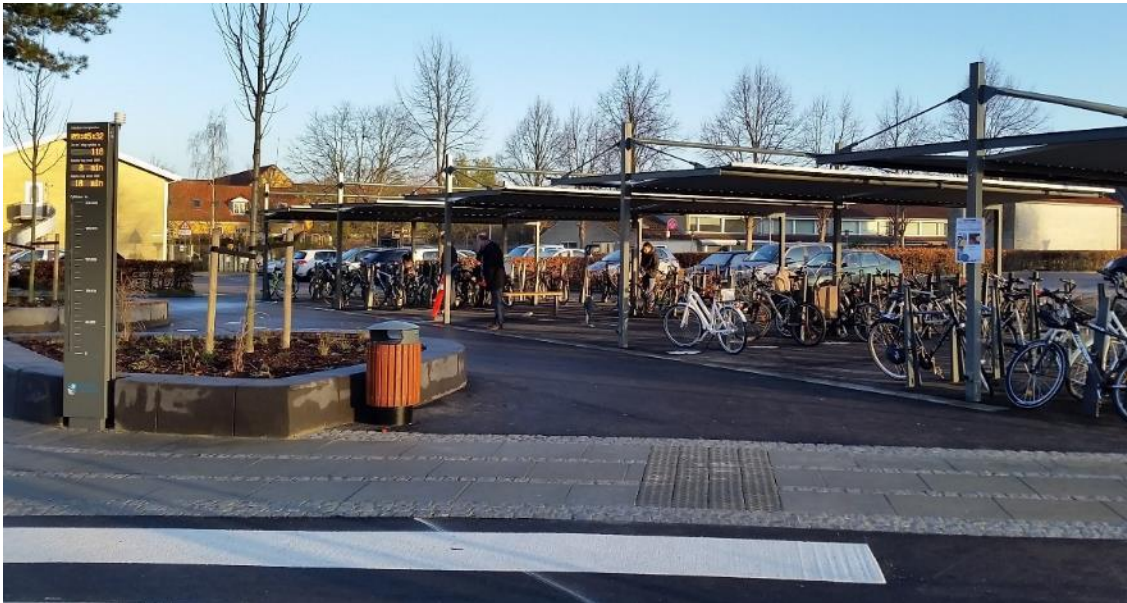
Figur 7.2 Cykelparkering ved centralt busstop langs supercykelstien Farumruten i Furesø Kommune. Her er direkte adgang til stien samt informationsstander med realtidsinformation om afgangstider for busser. Foto: Furesoe.dk.
