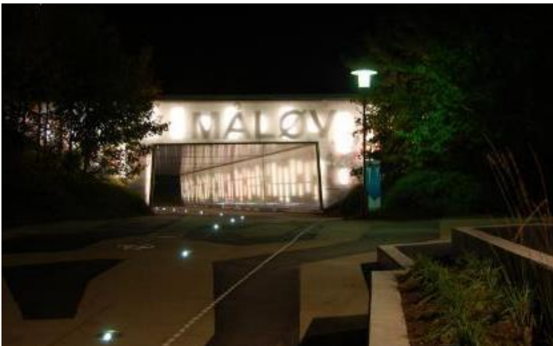
Figur 4.36 Eksempel på stitunnel ved Måløv Station, hvor belysning opfylder et funktionelt behov og giver en oplevelse på cykelturen. Lyset bliver desuden kraftigere, når der er aktivitet. Belægningen opfylder dog ikke anbefaling om adskillelse til fodgængere. Foto: Ballerup.dk.
