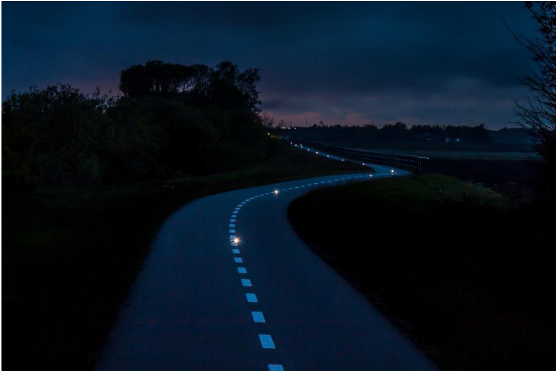
Figur 4.35 Eksempel på brug af diodebelysning som ledestjernesystem på dobbeltrettet sti mellem Tjæreborg og Esbjerg. Bredden på stien opfylder ikke anbefalingerne til en supercykelsti. Foto: Henrik Kongshøj Callesen, Esbjerg Kommune.
