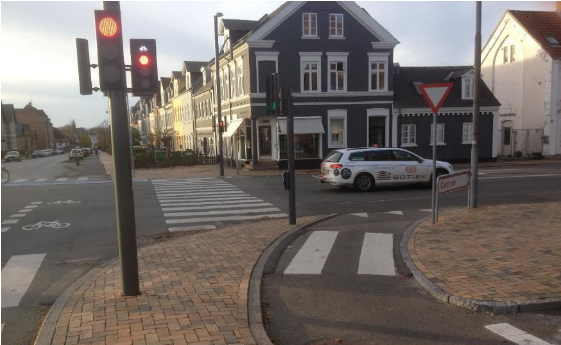
Figur 4.28 Cykelshunt i Odense, der leder højresvingende cyklister uden om signalanlægget. Fodgængerfelt anbefales jf. håndbog "Færdselsarealer for alle". Foto: Odense Kommune.
