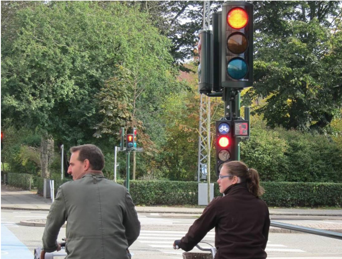
Figur 4.29 Nedtællingssignal i signalkryds, Albertslundruten i Frederiksberg Kommune. Foto: Supercykelstier Region Hovedstaden.
