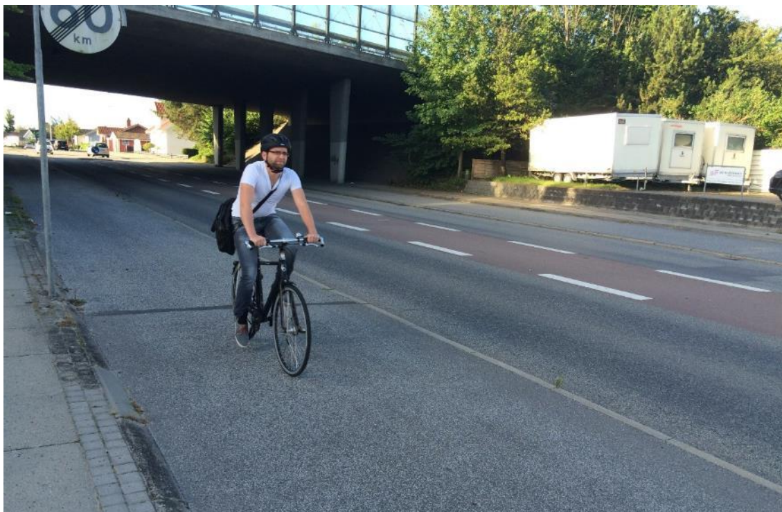
Figur 4.5 Enkeltrettet sti på 2,5 m langs pendlerruten på Gugvej i Aalborg. Foto: Brian Høj, Aalborg Kommune.
