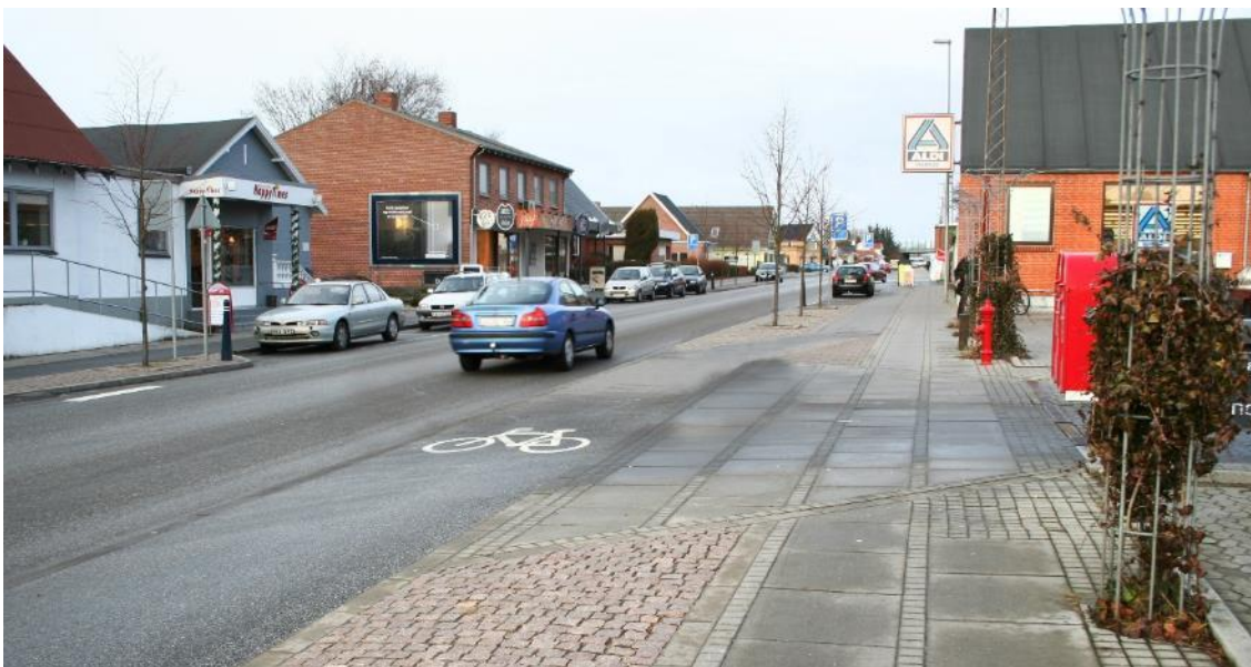
Figur 4.26 Overkørsel ved sidevej, hvor cykelstien er ført ubrudt gennem krydset, Aalborg Kommune. Foto: COWI.
