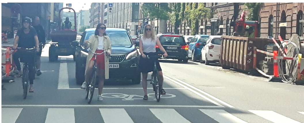
Figur 5.6: Eksempel på cykelboks på Njalsgade i Københavns Kommune.
