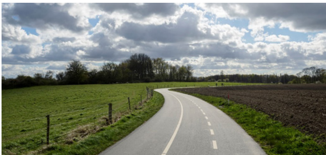
Figur 4.5: Eksempler på dobbeltrettet cykelsti i eget tracé udformet som en delt sti, hvor fodgængere kun er adskilt herfra med en afmærkning. Stien er i landzone, og der færdes meget få fodgængere (Værløseruten).
