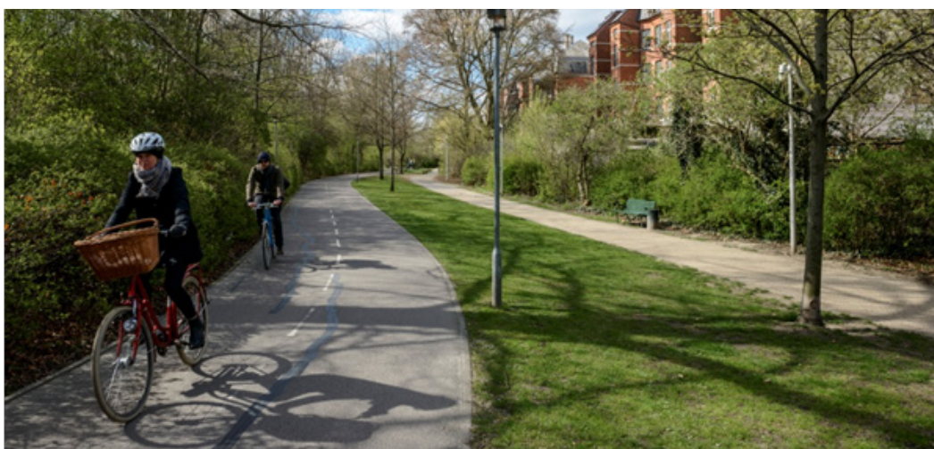
Figur 4.3: Eksempel på dobbeltrettet cykelsti i eget tracé, hvor fodgængere er klart adskilt herfra med græsabat. På strækningen færdes både mange cyklister og fodgængere (Indre Ringrute, Frederiksberg Kommune).
