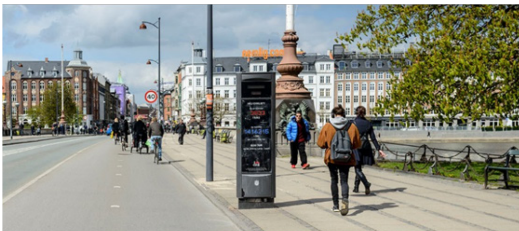
Figur 4.9: Eksempel på bred enkeltrettet cykelsti langs trafikvej i byområde. Foto fra Farumruten og Frederikssundruten, Københavns Kommune.
