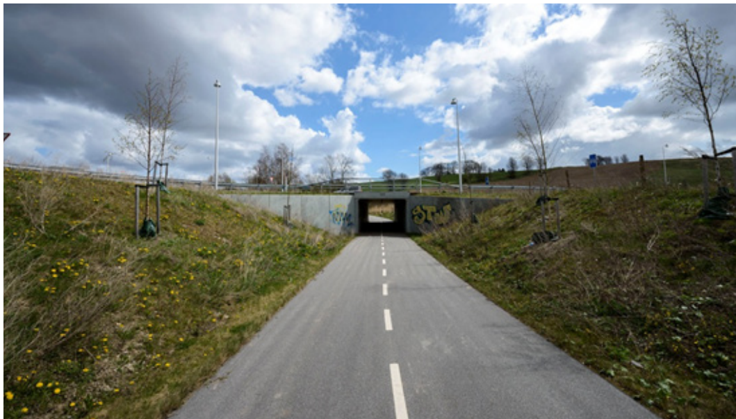
Figur 5.1: Krydsning ude af niveau via en tunnel på Frederikssundruten.
