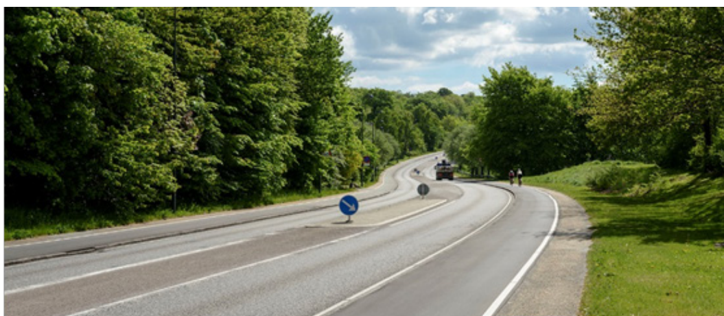
Figur 4.10: Eksempel på enkeltrettet delt sti langs vej i åbent land. Cyklister og fodgængerens areal er adskilt ved belægningsskift samt afstribe (Allerødruten, Rudersdal Kommune).
