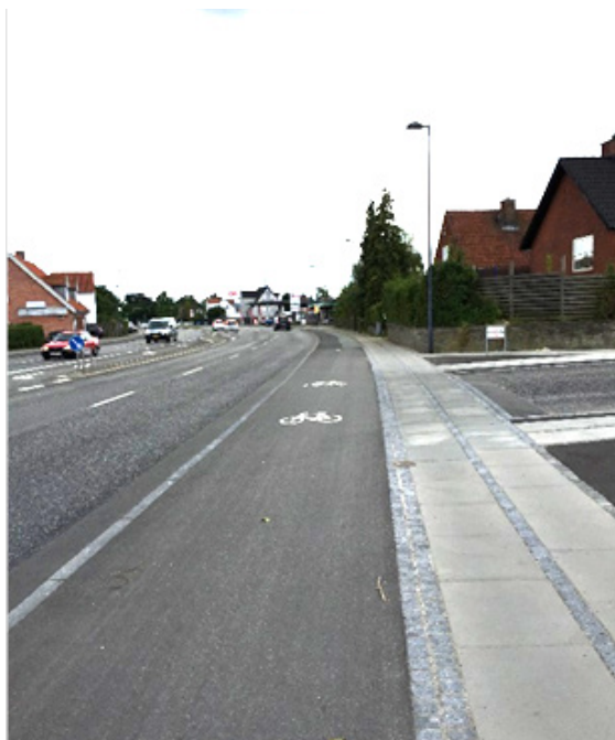
Figur 5.10: Eksempel på gennemført Supercykelsti ved sidevej på Ring 4 ruten i Ballerup Kommune.
