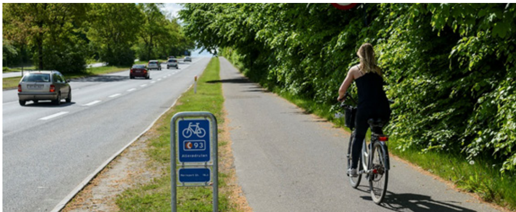
Figur 4.11: Eksempel fra Allerødruen, Rudersdal Kommune, enkeltrettet cykelsti langs trafikvej i åbent land. Hastighedsgrænsen er 70 km/t og dermed krav om en skillerabat. Der er ikke særskilt areal for fodgængere, hvormed stien er fællessti, hvilket ikke anbefales generelt. Et alternativ ville være en delt sti, hvis der er få fodgængere.
