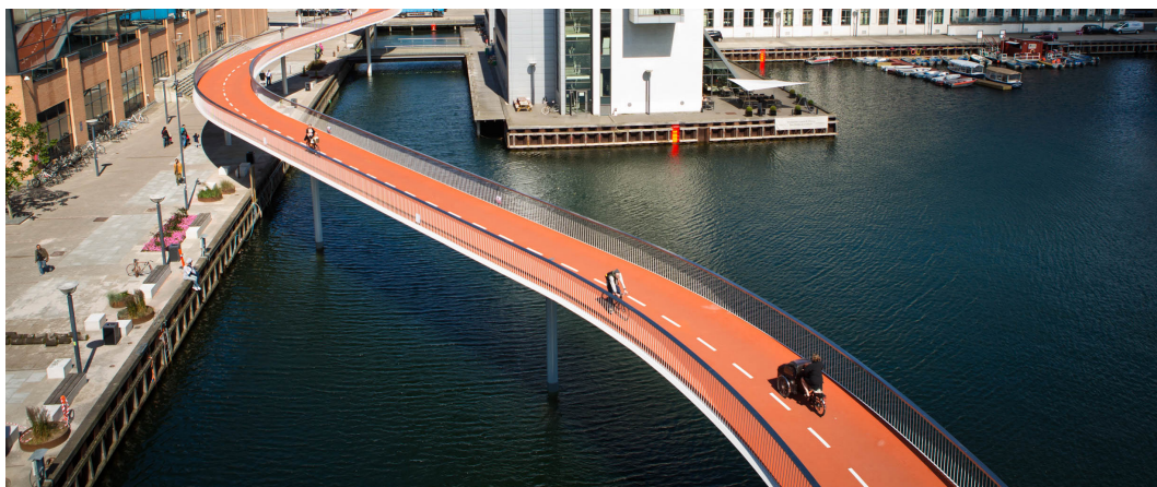
Figur 4.4: Eksempel på dobbeltrettet cykelsti i eget tracé som bro, Cykelslangen (Søruten, Københavns Kommune).
