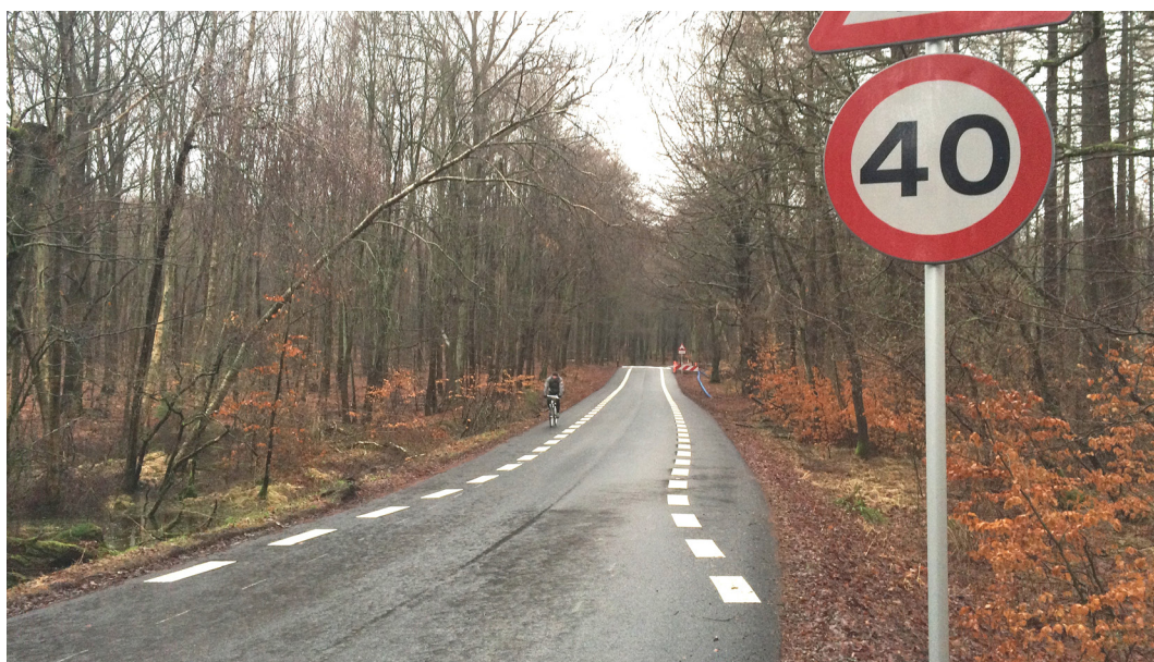
Figur 4.16: Eksempel på 2 minus 1 vej i åbent land med hastighedsreduktion på 40 km/t på strækningen (Farum-Allerødruen, Allerød Kommune).
