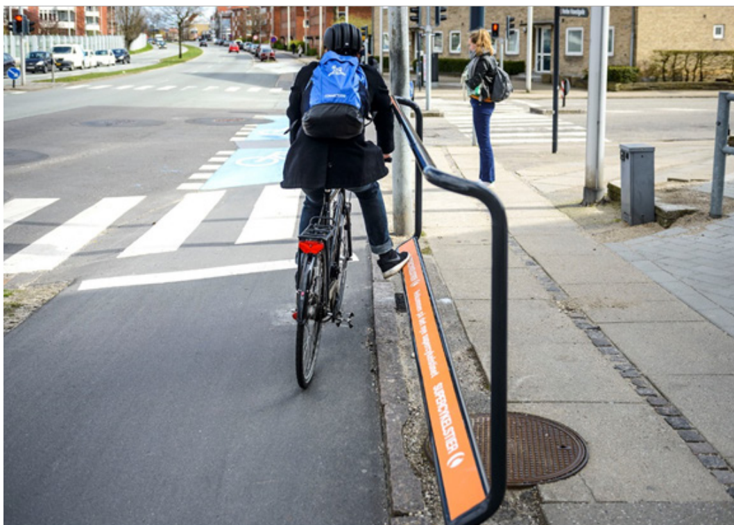
Figur 9.3: Eksempel på fodhviler ved signalkryds, her på Frederikssundsruen i Herlev Kommune.
