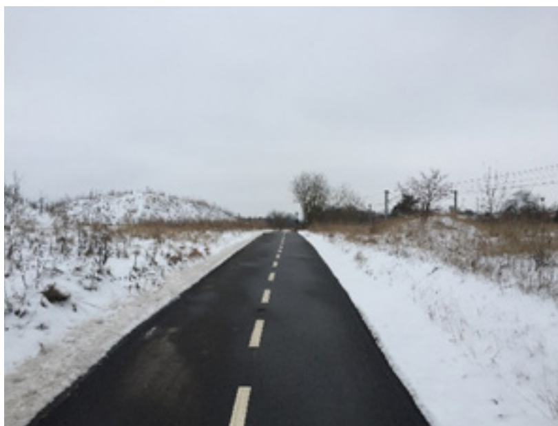
Figur 10.1: Eksempler på dårlig vinterdrift af enkeltrettet cykelsti langs vej (foto øverst) og god vinterdrift på sti i eget tracé (foto nederst).
